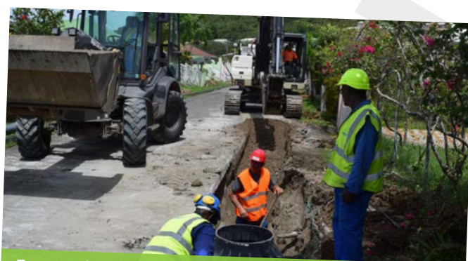
Travaux d'amélioration du réseau d'assainissement au lotissement « Les Moubins » : point d'étape
