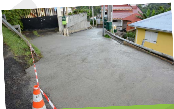
Réfection de la voie Salomon, au quartier Bellay
