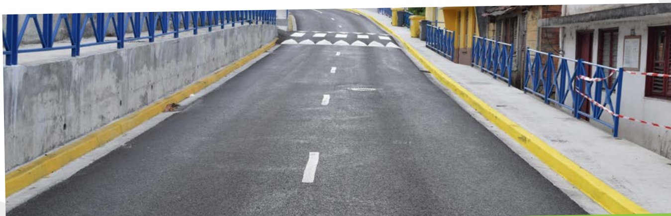
Fin des travaux de l'aménagement de l'entrée de bourg Est
