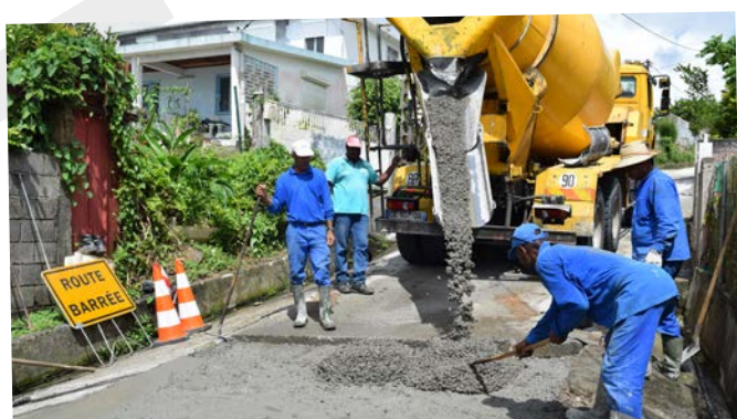
300 mètres linéaires réhabilités à la Voie Caraïbe
