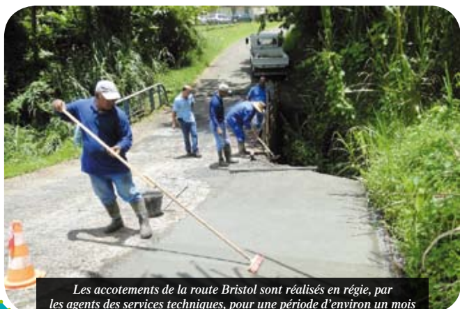
Le Conseil Général a entrepris la réparation de la RD36, à Monésie à hauteur du lieu-dit Grand Fleur
